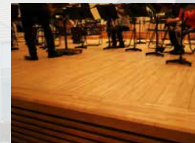
▲ナラ材を使用した縦引きの床
